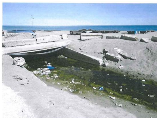
Supuesto emisario de “pluviales” con salida a la playa
