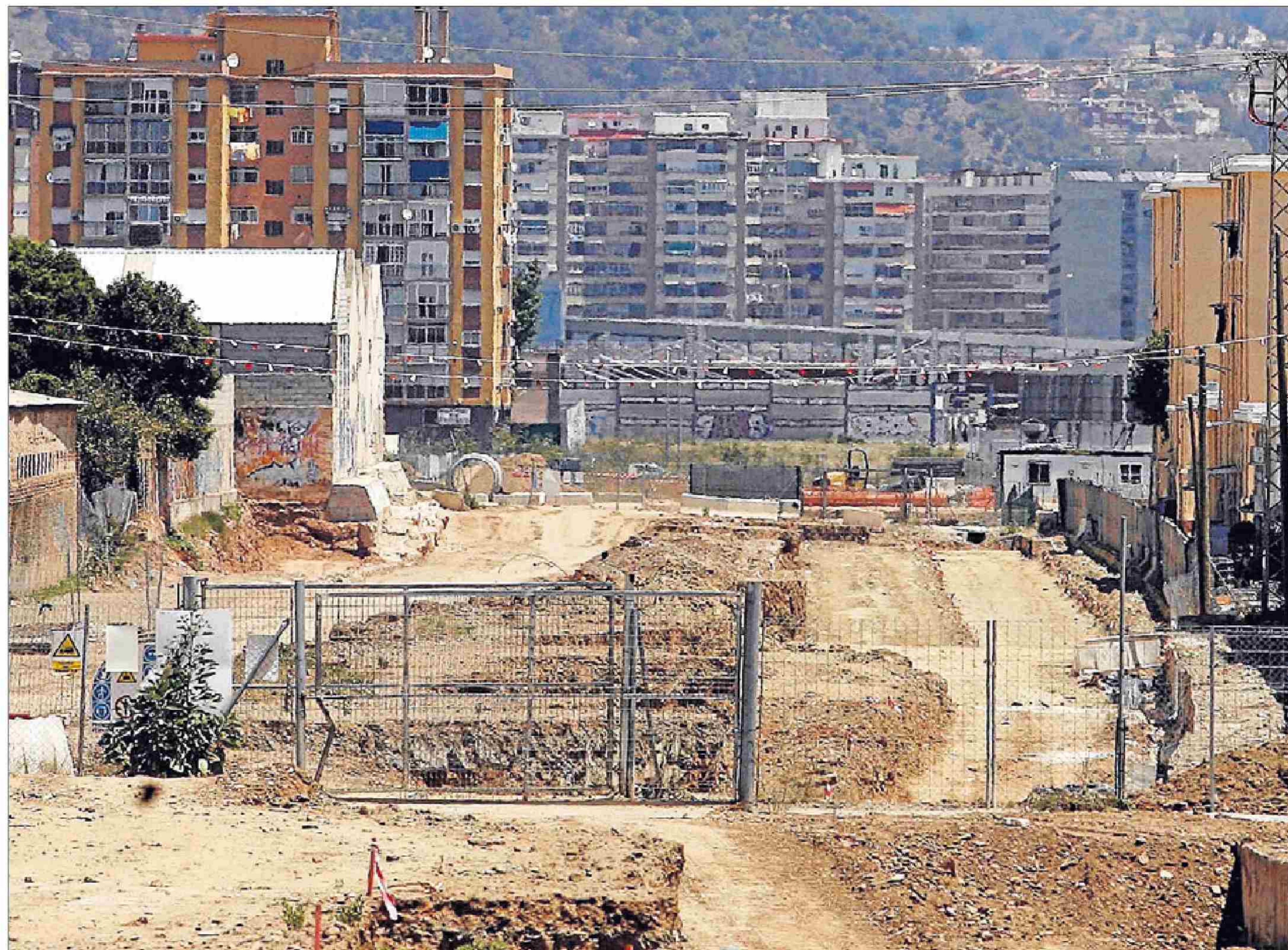
Los trabajos de construcción del bulevar comenzaron en enero con un presupuesto de 12,2 millones de euros. GREGORIO TORRES
