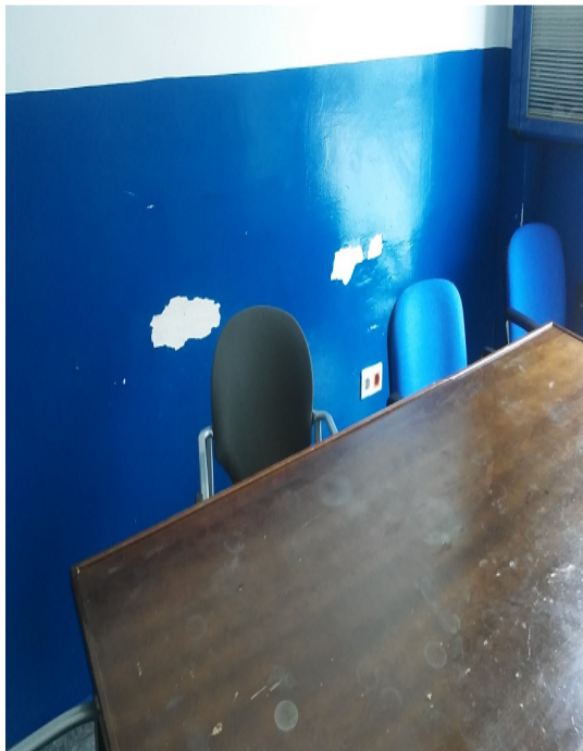
REPARACION DE PARAMENTOS
