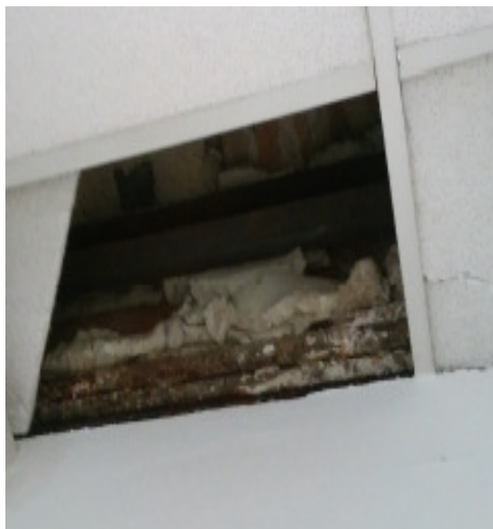
REPARACION DE UMBRALES
