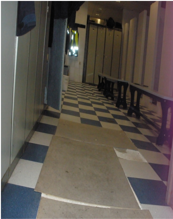
SOLERIA EN VESTUARIOS
