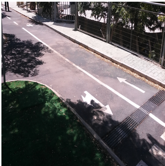
REPARACIONES EN PAVIMENTOS SEG VIAL
