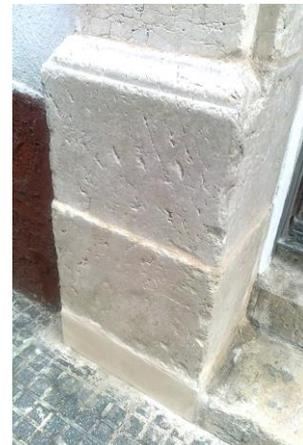
Arco de entrada, detalle de cancela de fundición y plinto de piedra caliza.
