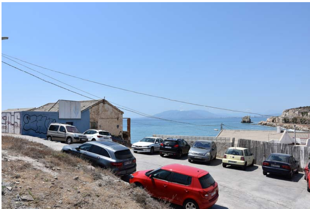
Vista general desde el sureste
