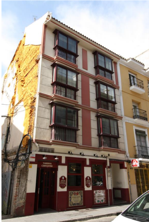
Fachada Edificio C/ Álamos 8 Cubierta inclinada
