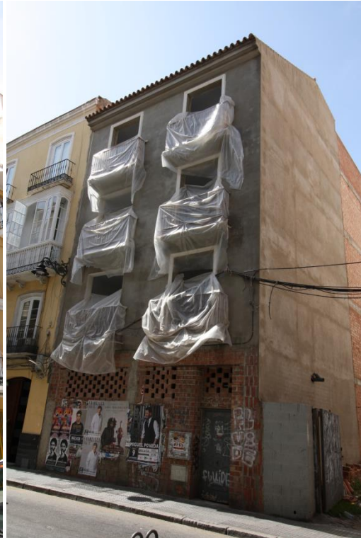
Fachada Edificio C/ Álamos 12 Cubierta inclinada
