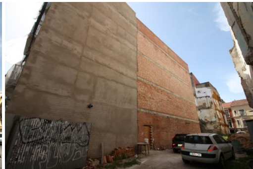
Medianera con C/ Álamos 12 (B+3) en construcción.
