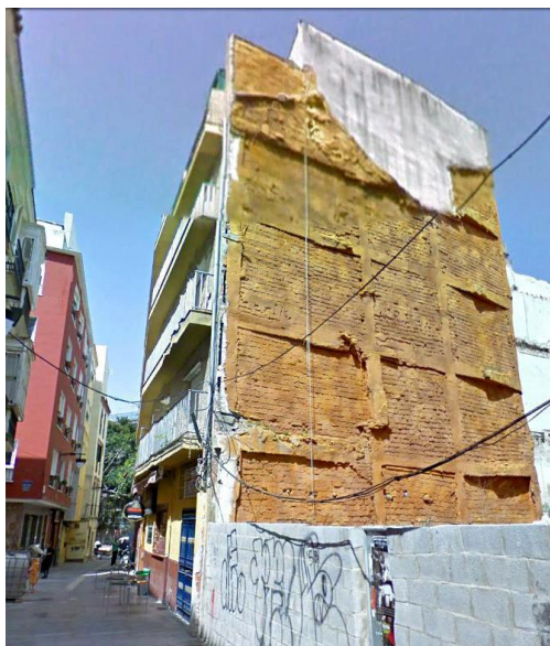
Fachada Edificio C/ Beatas 3 (B+4)
