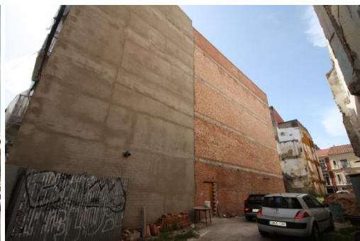
Medianera con C/ Álamos 12 (B+3) en construcción.
