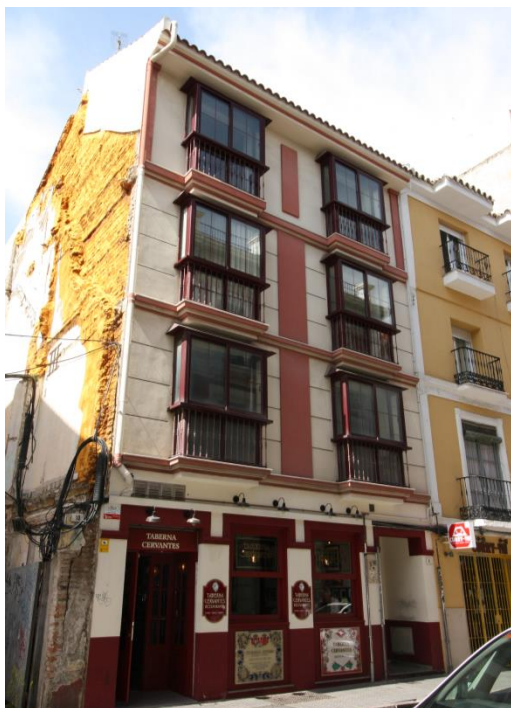
Fachada Edificio C/ Álamos 8 Cubierta Inclinada
