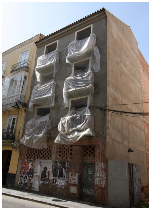
Fachada Edificio C/ Álamos 12 Cubierta Inclinada
