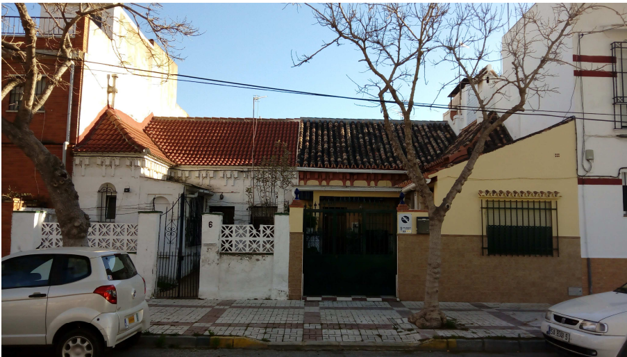
C/ Pintor Jaraba 4 y 6. El nº 4 es el único inmueble de la manzana que se mantiene sin alteraciones.
