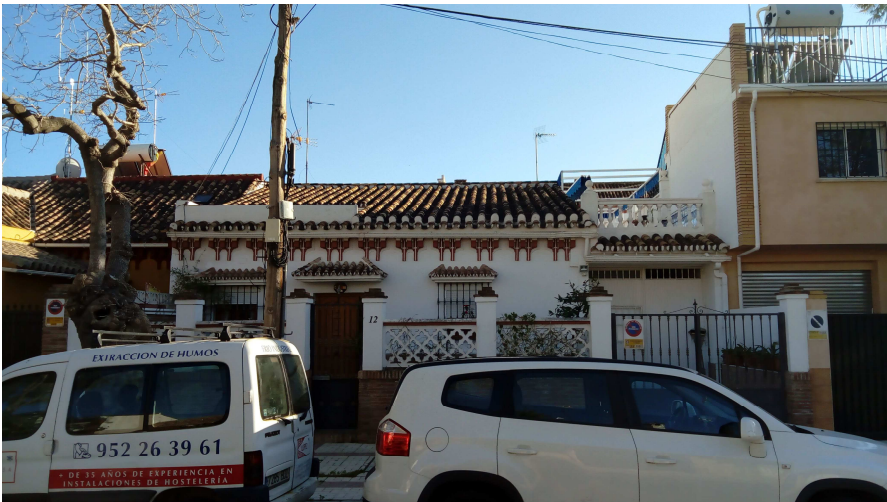
C/ Pintor Jaraba 12, reposición de los elementos ornamentales en la fachada ampliada.
