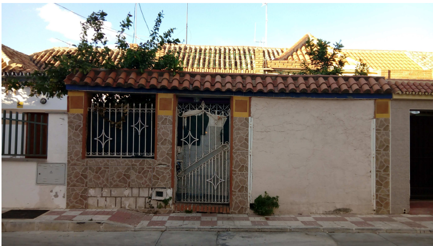
C/ Arquitecto Gonzalo Iglesias nº 15 y 13. Al igual que en el 17 las altas tapias cerradas impiden apreciar la configuración de las edificaciones.
