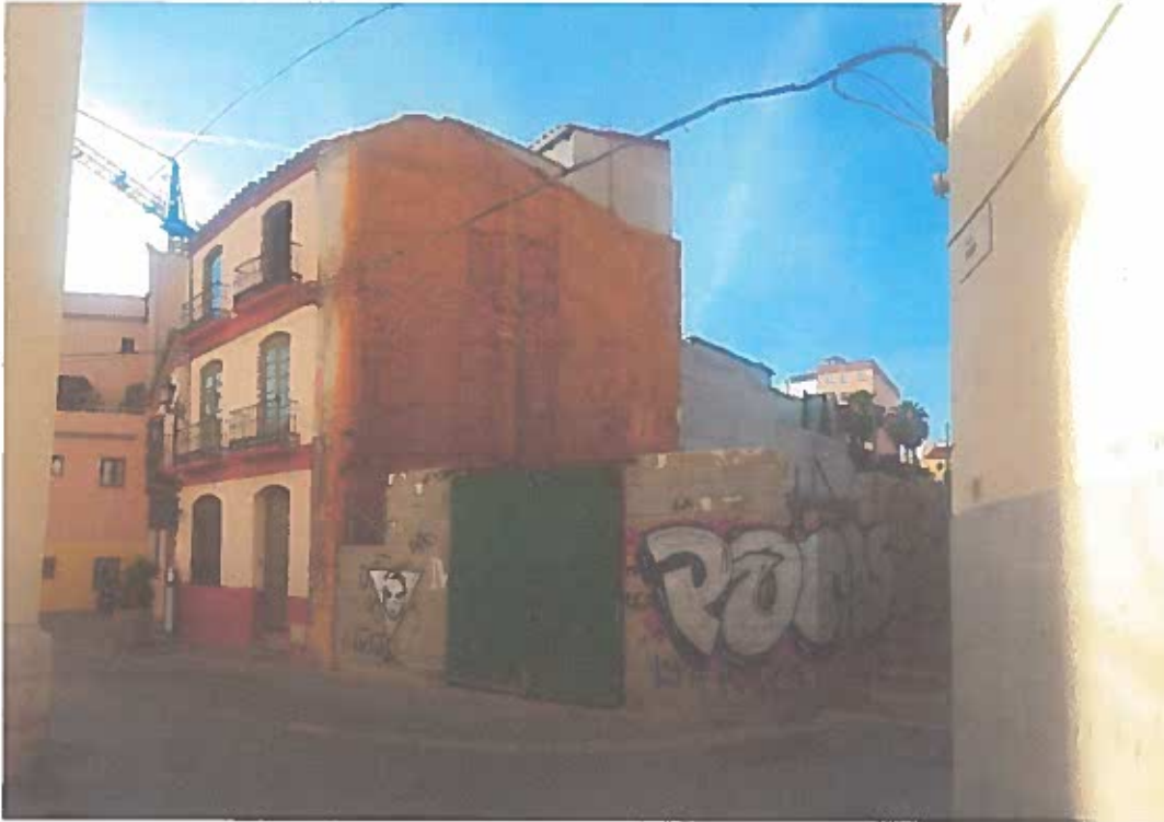
FACHADA A LA PLAZUELA DEL SANTÍSIMO CRISTO DE LA SANGRE
