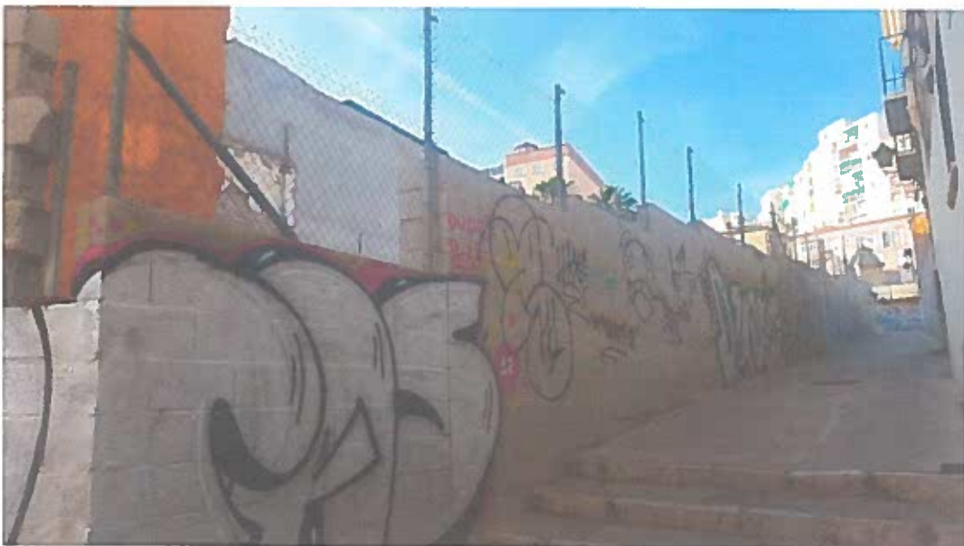
FACHADA A LA CALLE CHINCHILLA
