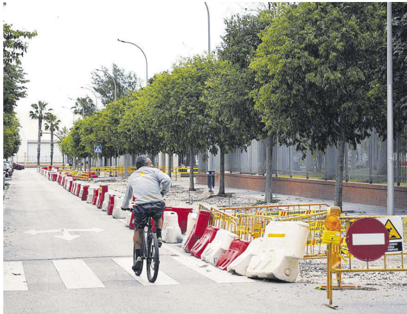
Inicio de las obras de la supermanzana de Huelin.
