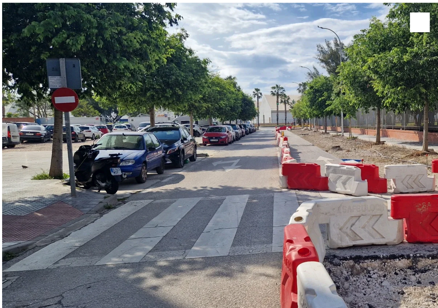
Obras que han empezado en la calle Orfila, para reducir la calzada y ampliar la acera. Salvador Salas
