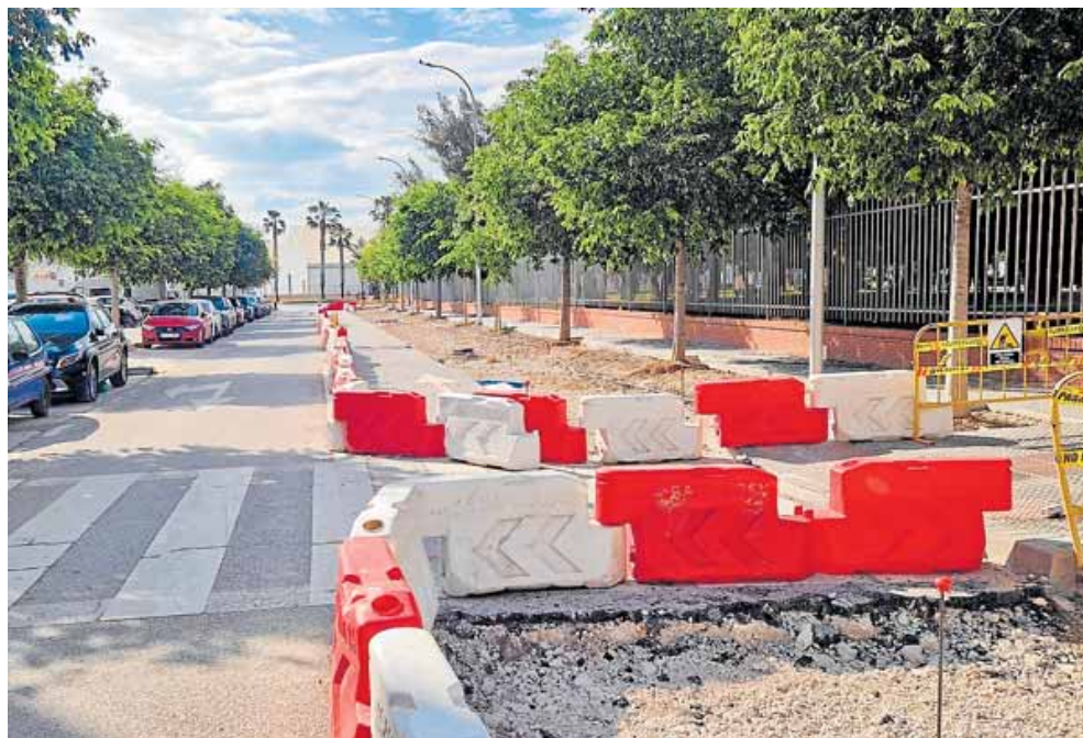
Obras que han empezado en la calle Orfila, para reducir la calzada y ampliar la acera. SALVADOR SALAS
