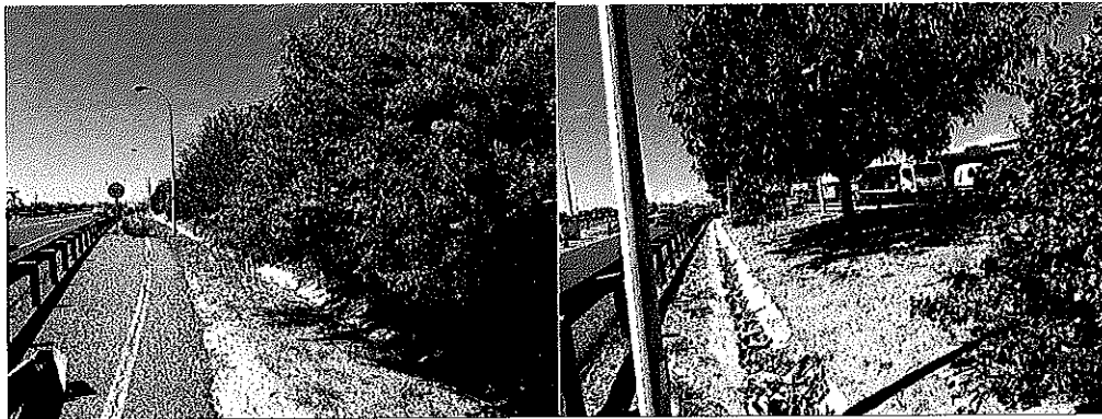
Imagen 5 y 6. Estado actual de talud entre Carrefour y MA-20
