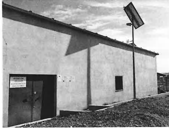
Balsa 1. Caseta de valvulería Toma 1. Exterior cerrado y señalizado
