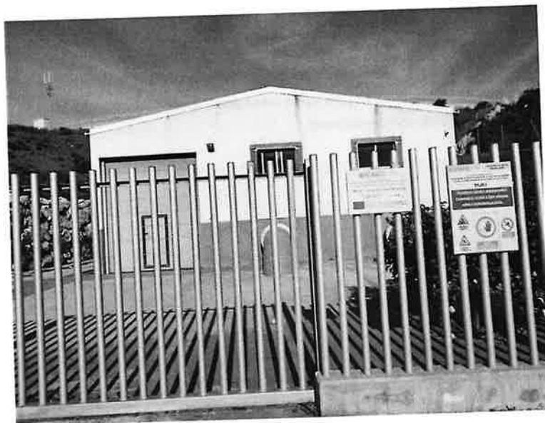
Balsa 1. Nave de valvulería. Cerramiento.
