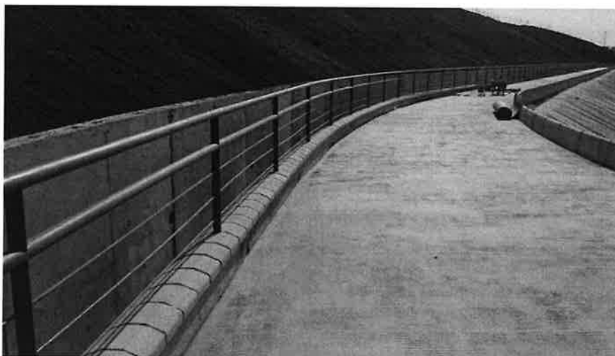
Balsa 1. Canal perimetral en coronación
