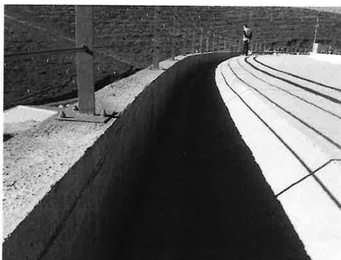
Balsa 1. Detalle cuneta en coronación
