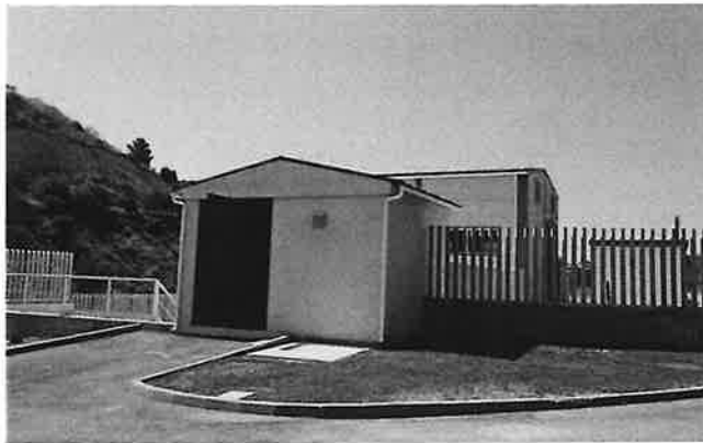
Caseta de bombas
