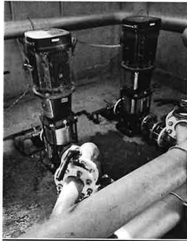
Bombeo agua regenerada al parque del Peñón del Cuervo
