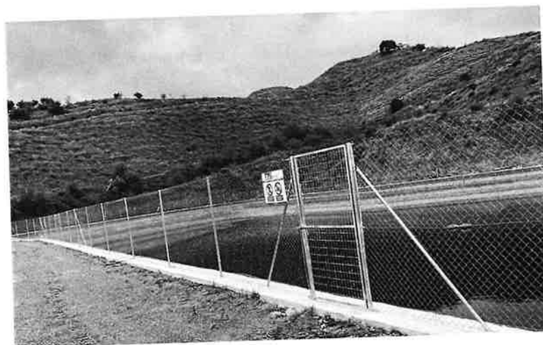
Balsa Huerta-Martí. Cerramiento, señalización y pretil
