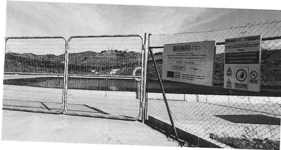
Balsa 1. Cerramiento perimetral y señalización
