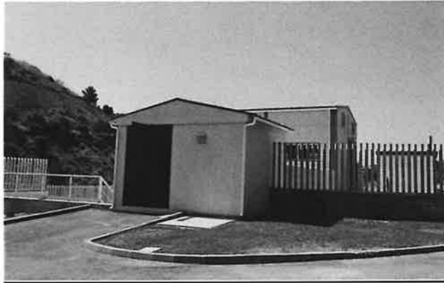
Caseta de bombas
