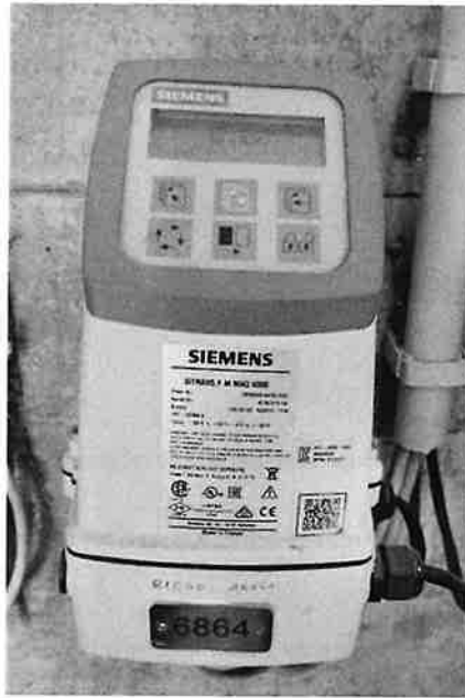
EDAR Peñón del Cuervo. Caudalímetro salida
