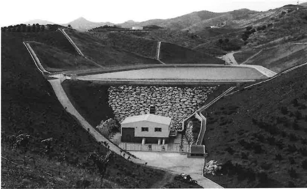
Balsa 1 de Regulación y mezcla, y nave de valvulería
