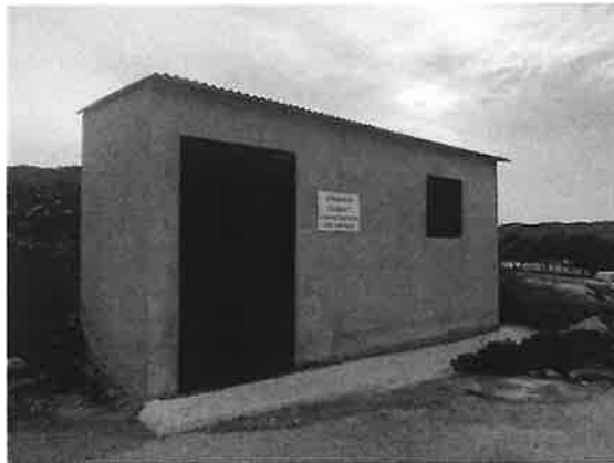
Caseta de Toma de Riego, cerrada y señalizada
