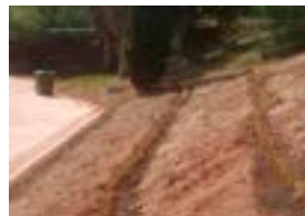
Retención de taludes con barreras naturales de vetiver
