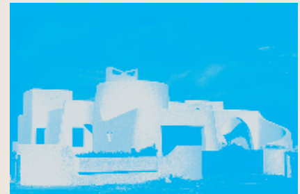
Diseño para vivienda en urbanización de Roquetas de Mar, Almería
