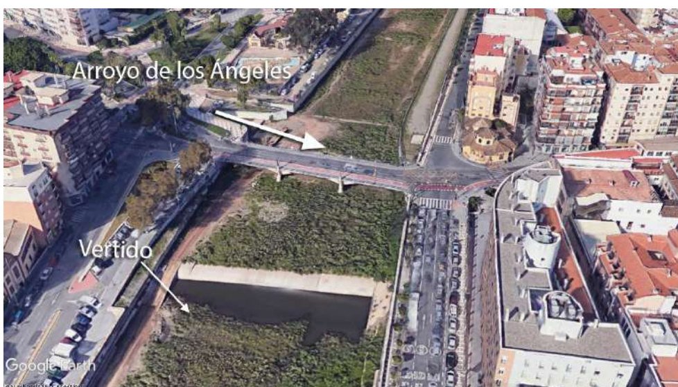
Imagen 37: Puente Armiñán y desembocadura de arroyo de los Ángeles. Fuente: Google Earth
