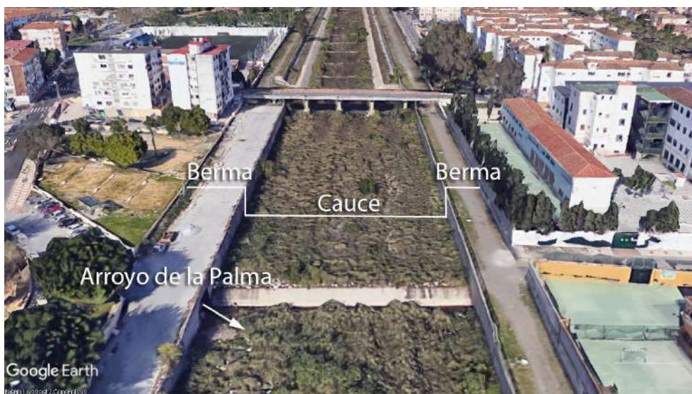
Imagen 25: Puente de la Palmilla y desembocadura de arroyo la Palma. Fuente: Google Earth
