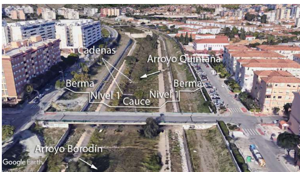
Imagen 21: Puente del Conservatorio, desembocadura de arroyos Quintana y .Borondín Fuente: Google Earth
