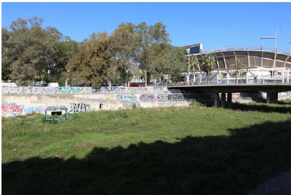
Imagen 35: Vertido urbano aguas abajo puente de la Rosaleda
