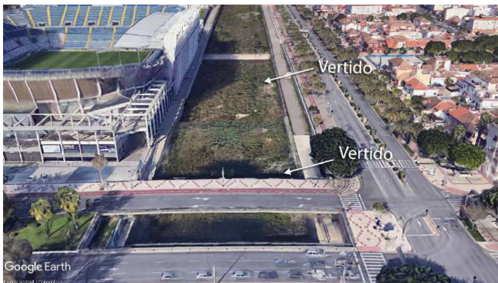
Imagen 32: Tableros norte y sur puente de la Rosaleda. Fuente: Google Earth
