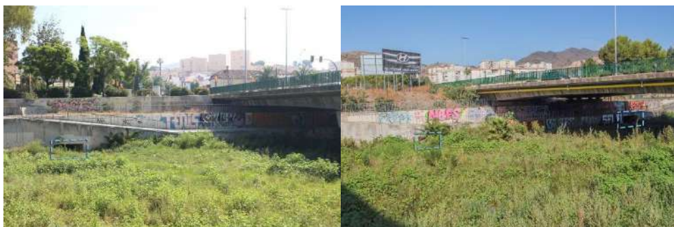
Imagen 29: Vertido en margen izquierda y margen derecha
