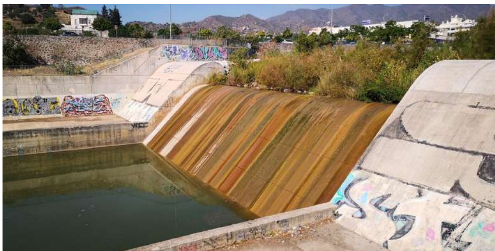
Imagen 19: Rápida de hormigón
