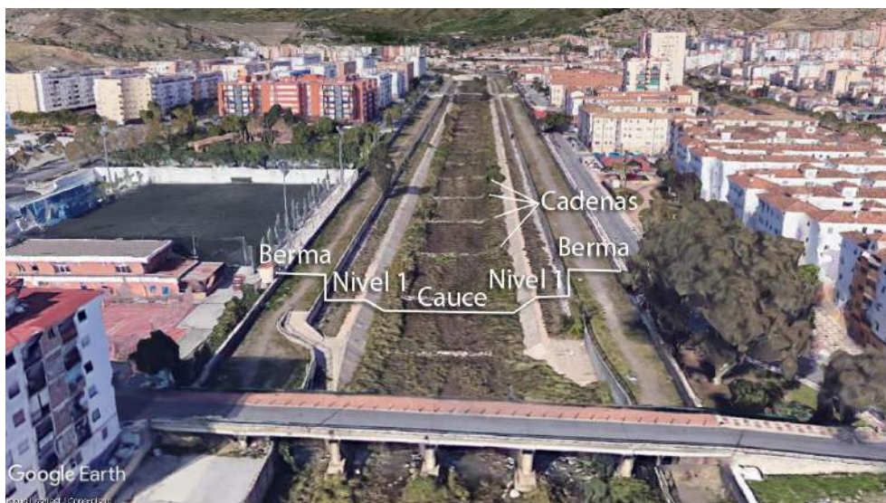
Imagen 24: Puente de la Palmilla. Fuente: Google Earth
