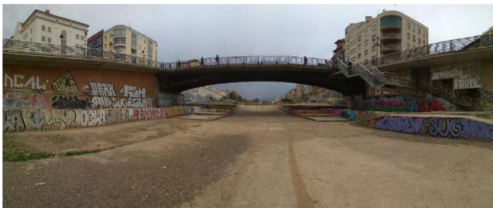
Imagen 45: Acceso a cauce en puente de la Aurora. Fuente: Google Earth
