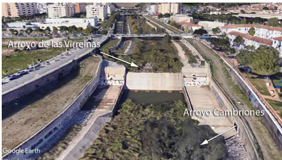
Imagen 17: Puente del Conservatorio, desembocadura arroyos Virreinas y Cambrones. Fuente: Google Earth
