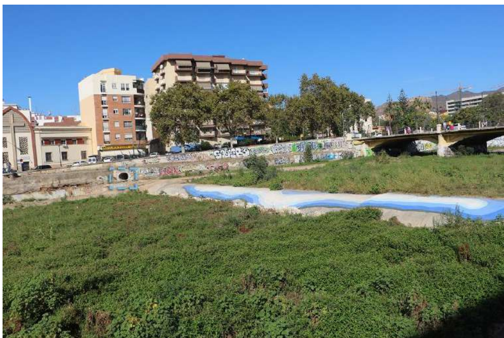
Imagen 39: Vertido urbano aguas abajo de puente de Armiñán
