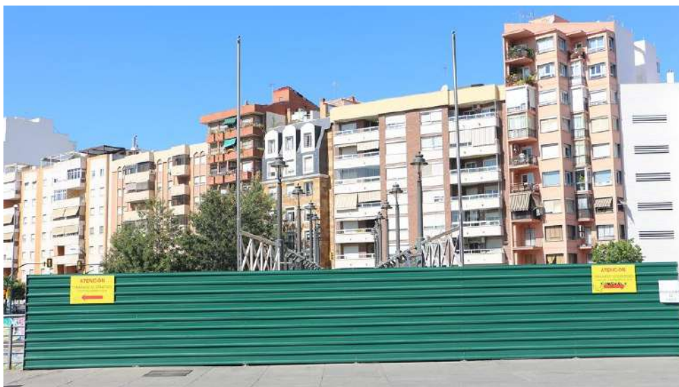
Imagen 54: Obras en puente de Perchel
