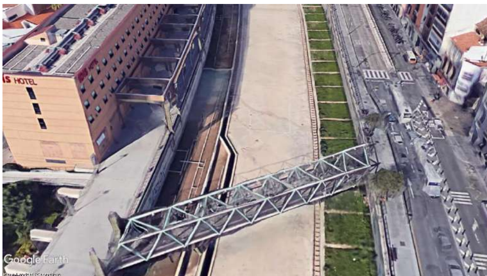
Imagen 46: Puente de la Esperanza. Fuente: Google Earth
