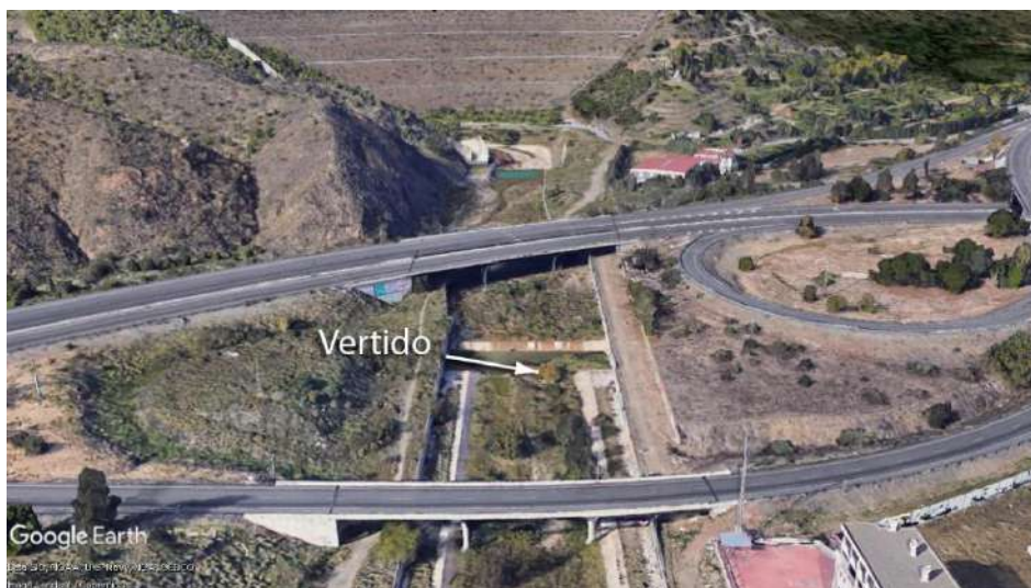
Imagen 11: Puentes de la Autovía y Salida 241. Fuente: Google Earth
