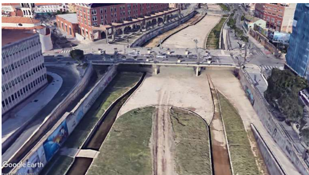
Imagen 49: Puente de la Esperanza. Fuente: Google Earth
