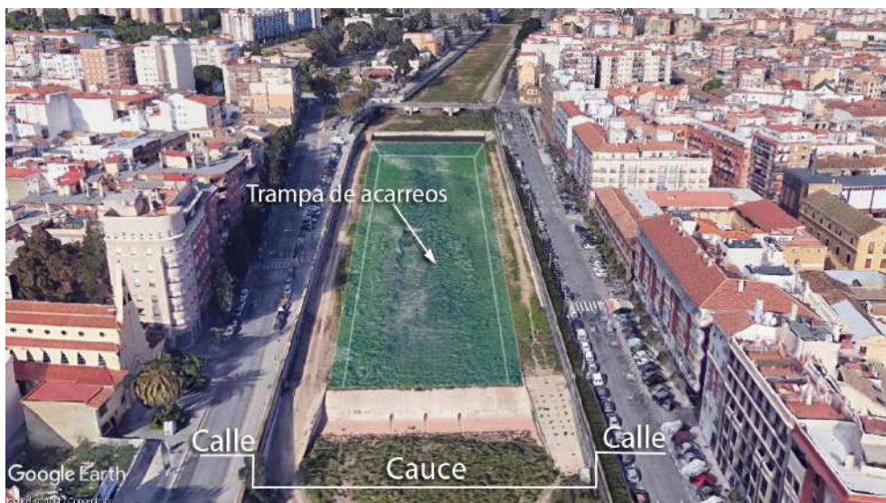
Imagen 40: Trampa de acarreo aguas abajo de puente de Armiñán. Fuente: Google Earth
