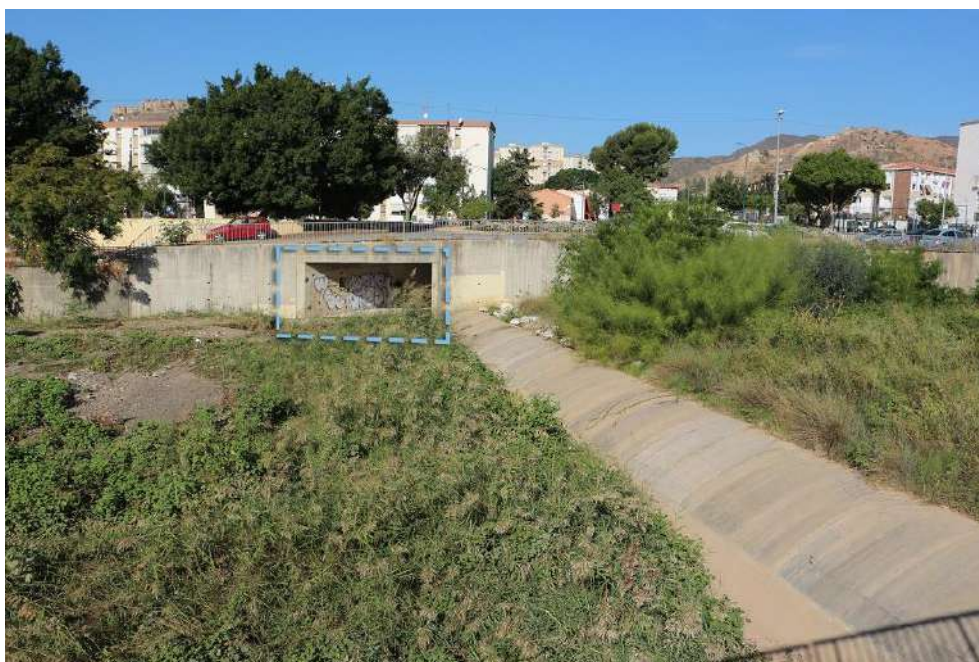
Imagen 26: Desembocadura de arroyo la Palma y rápida de hormigón
