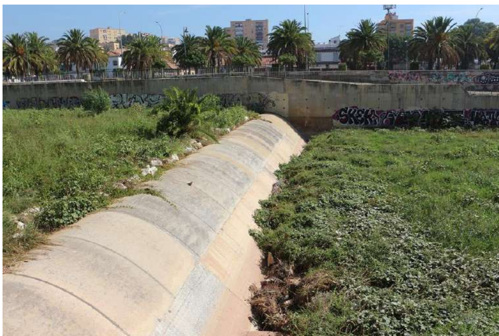
Imagen 33: Rápida de hormigón entre puentes Mediterráneo y Rosaleda
