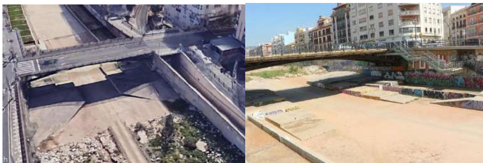
Imagen 43: Estructuras de hormigón bajo puente de la Aurora. Fuente: Google Earth
