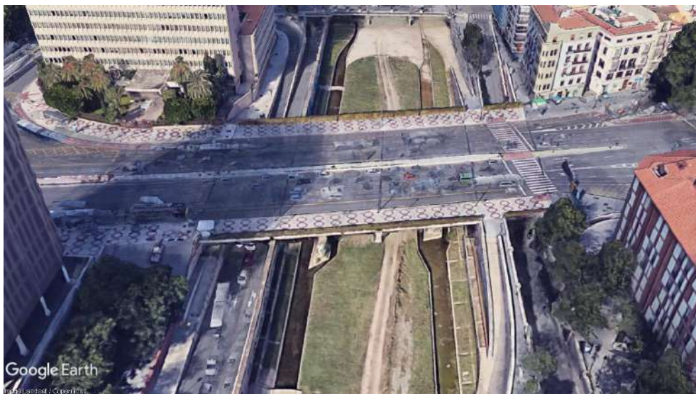
Imagen 50: Puente de Tetuán. Fuente: Google Earth
