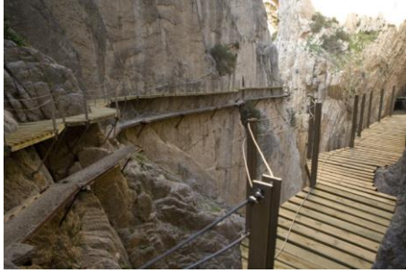
Luis Machuca Arquitectos. Rehabilitación Caminito del Rey, Álora.
